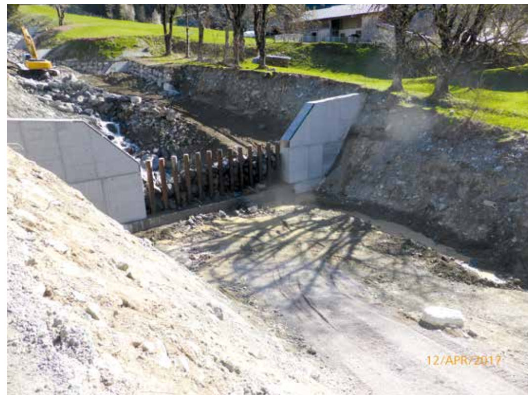
Abb. 6: „Kamm Sperre“ vor Hinterfüllung
